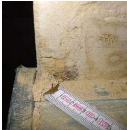
Der Hund ignorierte die Putzverfärbungen, markierte aber sehr auffällig den fertig gedämmten und mit einer Dampfbremse versehenen Dachbereich.
